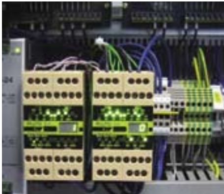
Le concept de commande modulaire avec le PLC de sécurité Pluto de Jokab Safety.
