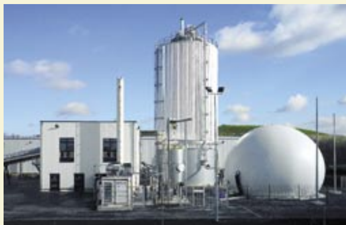
Pour le moment, OWS a appliqué le procédé Dranco à une vingtaine d'installations. La photo montre une installation située à Münster en Allemagne, traitant 24.000 tonnes de déchets ménagers par an. (photo: OWS)
