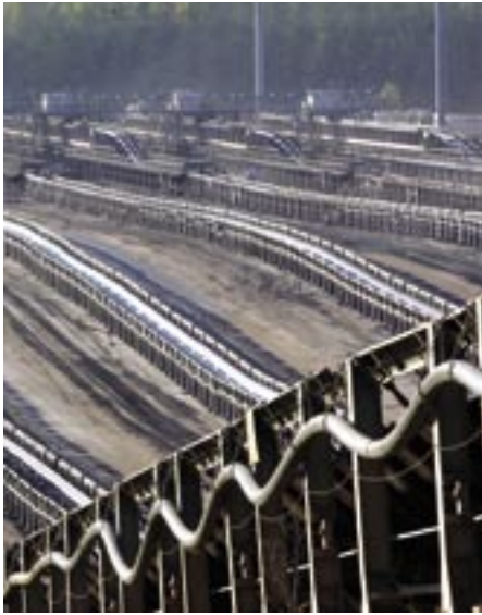
Le centre névralgique de la mine de lignite à ciel ouvert de Garzweiler: le matériau est distribué par la station de répartition de Jackerath aux sections de transport longue distance. (Photo: RWE Power AG)
