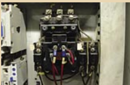
Les connexions de cette pompe d'évaporation présentent un excès de 50 degrés à la phase C.
