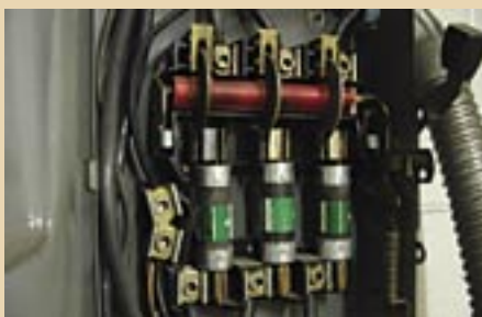
Les mesures de température montrent que les connexions sur les phases A et B de ce tableau électrique sont chaudes, laissant supposer une charge déséquilibrée.
