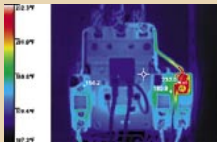
Les connexions de cette pompe d'évaporation présentent un excès de 50 degrés à la phase C.
