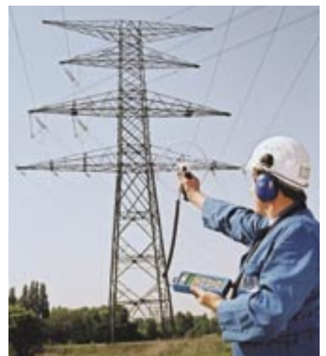
Inspection électrique avec le capteur ultrasonore parabolique.
