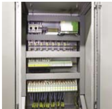
Les nouvelles mesures ont conduit à placer un boîtier de commande supplémentaire contenant notamment des transformateurs de courant de Phoenix Contact.
