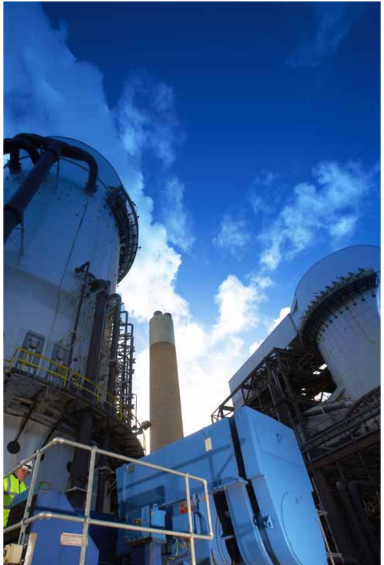
La centrale électrique de Ratcliffe, une des centrales thermiques au charbon les plus efficaces du Royaume-Uni, a été mise en service en 1993 et sert à diminuer largement les émissions SO 2 . (photo: WEG)
