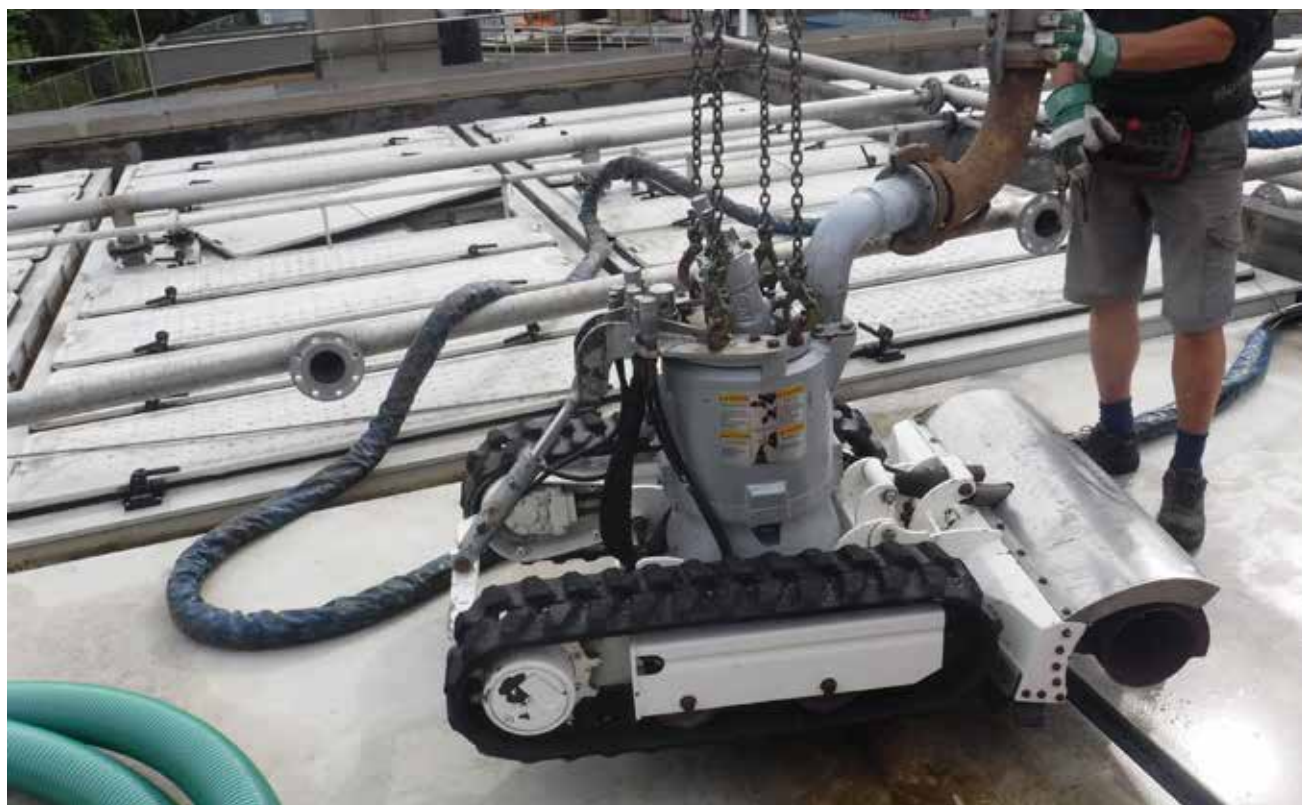
ROV cleanet slibtanks van de waterzuivering (Foto: Van de Velde pipe inspections & solutions)
