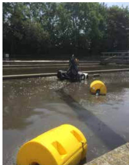
ROV reinigt waterzuivering in productie (Foto: Van de Velde pipe inspections & solutions)
